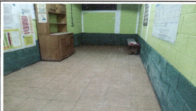
Foto 3: MODULO 3: Colocacion de piso ceramico en la direccion.
