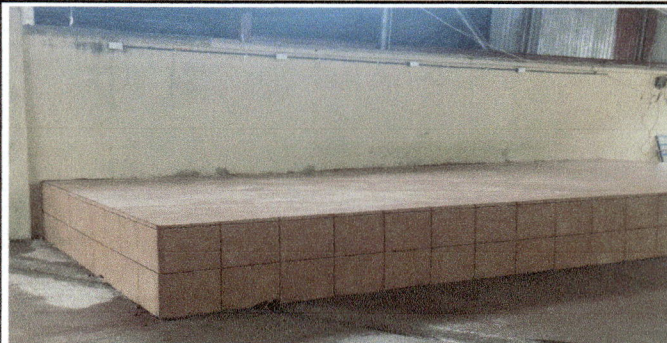
Foto 2: MODULO 2 : Colocacion de esecario y colocacion de piso ceramico.
