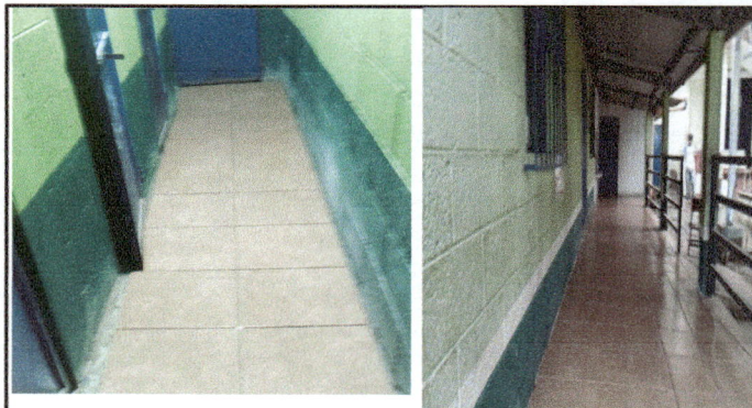
Foto 4: MODULO 3: Colocación de piso cerámico en sanitarios.
