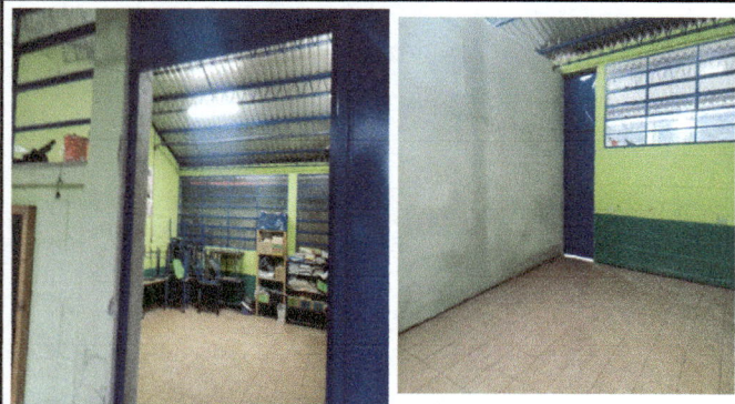
Foto 1: MODULO 1: colocacion de piso ceramica en la aula de prepa y colocacion de puertas y ventanas.
